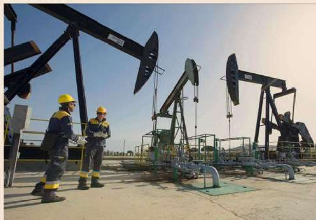
Dal petrolio al metano. Uno degli oltre 100 pozzi di petrolio di Gela. L'attività si sposta verso l'energia verde e verso l'estrazione del gas nel Canale di Sicilia
